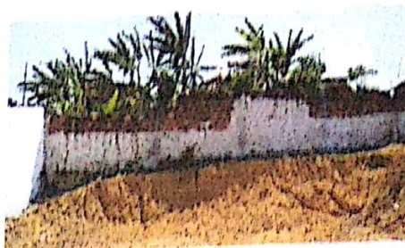
MURO POR TRÁS DA ESCOLA
