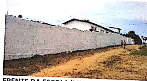
FRENTE DA ESCOLA/MURO
