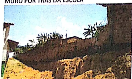
MURO POR TRÁS DA ESCOLA
