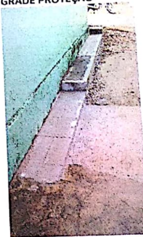
RECUPERAÇÃO DE CALÇADA
