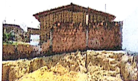
MURO POR TRÁS DA ESCOLA
