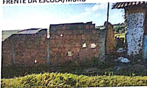
FRENTE DA ESCOLA/MURO
