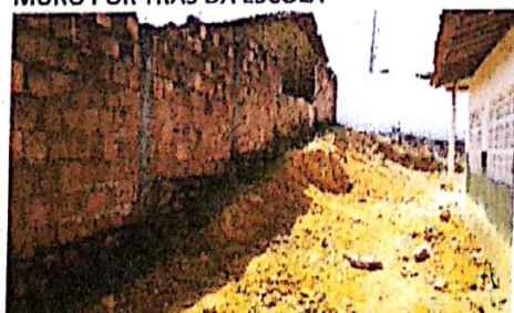
MURO POR TRÁS DA ESCOLA
