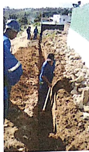
FRENTE DA ESCOLA/MURO
