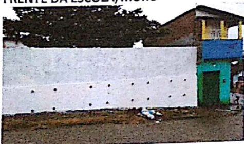
FRENTE DA ESCOLA/MURO
