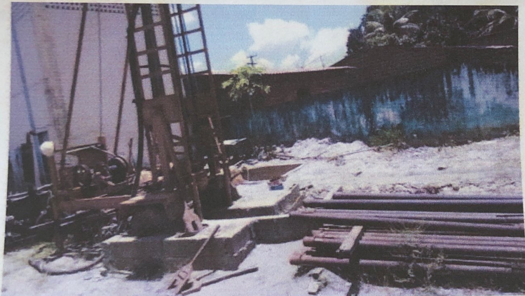
Figura 5 - Máquina e Equipamentos da Época da Perfuração (foto de março de 2016).
