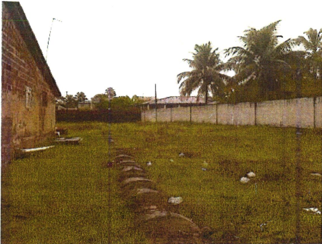
Caixa coletora e dicipadora das águas pluviais canalizadas a partir da tubulação implantada no primeiro segmento do terreno
