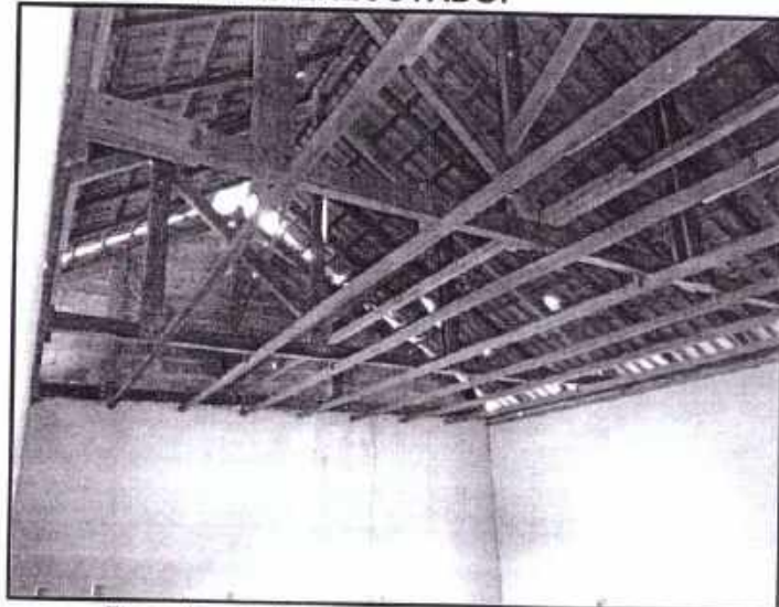
Figura 10 – Ambiente sem instalação de forro de PVC.
